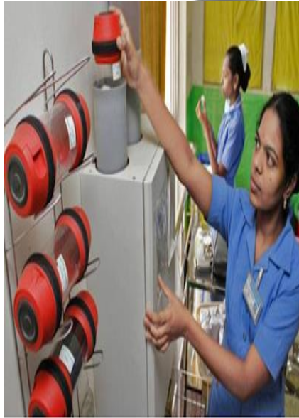
Resim 2.3: Pnömatik taşıma sistemi
